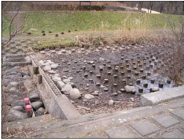
写真① 2月12日 取水堰
