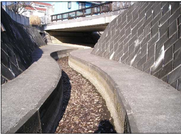
写真③ 2月17日 鞍尾根橋上流
